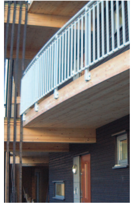
Massivtre brukt som balkonger og svalganger har vist seg å være meget praktisk.
