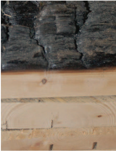
Brannforsøk utført ved brannlaboratorier kan dokumentere at et etasjeskille av massivtreelementer med tykkelse 160 mm krysslagt element med 5 sjikt med eksponert over- og underside oppfyller funksjonskravene REI 90. Massivtreelementene var forbelastet med 3 kN/m 2 .
