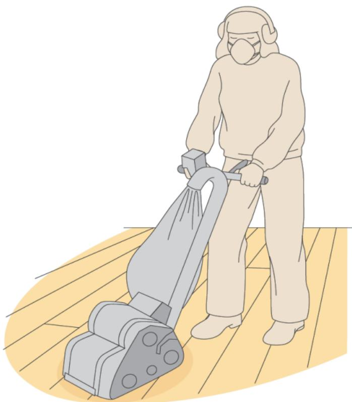
**Oppussing.** Har gulvet fått mye riper og er dårlig vedlikeholdt, kanskje har det også fått slag- og trykkmerker, vil det være aktuelt å slippe ned hele overflaten med en slipe-maskin. Når det er gjennomført, kan man igjen behandle overflaten som man ønsker.
