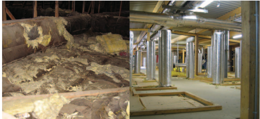
Figur 4. Tørkeloft med henholdsvis dårlig og god isolasjon.
