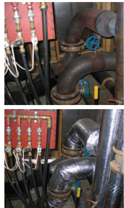
Figur 5. Isolering av rør med vannbåren varme gir store energibesparelser.
