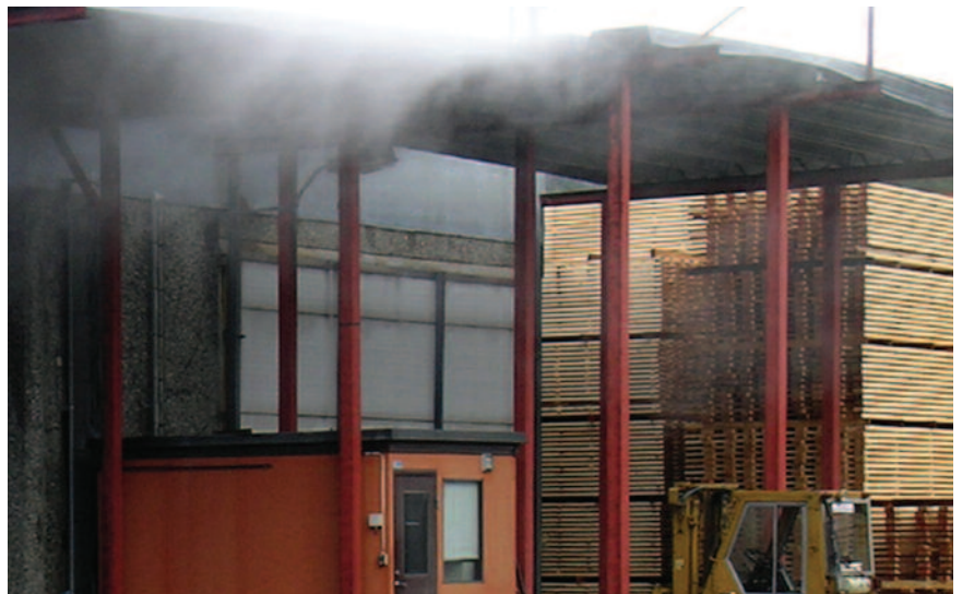
Figur 3. Lekkasjer fra trelasttørker medfører store varmetap.
